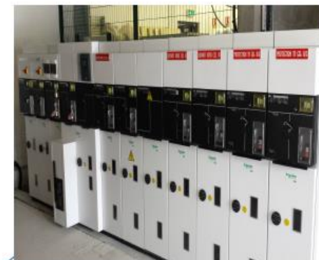
Cellule Haute Tension permet la mise sous ou hors tension de portions d'un réseau électrique à haute tension.
