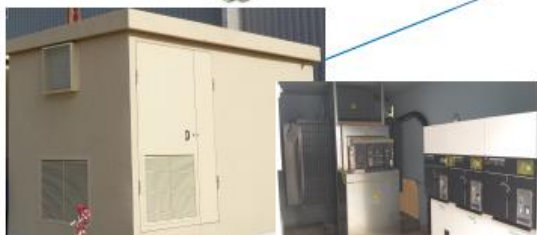
Poste Préfabriqué (Transformateur, Disjoncteur général et Cellule H.T)
